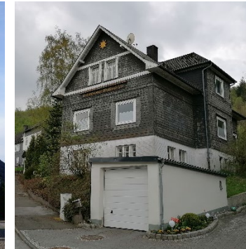
Ortsbildprägendes Gebäude Zum Park
