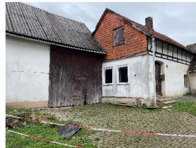
Sanierungsbedürftiger Hof Zur Padbeck
