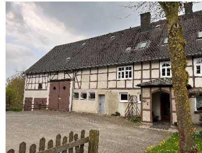
Denkmalgeschützter Hof im Ortskern
